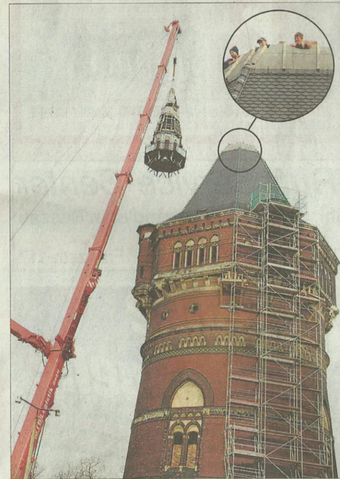
Die Aktion am Wasserturm lockte viele Schaulustige an. Den besten Blick hatten dann aber die mutigen Monteure.
