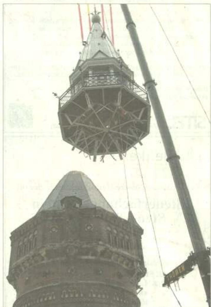
Präzisionsarbeit für Kranführer und Montagearbeiter. Trotz aufkommenden Windes verliefen die Arbeiten wie am Schnürchen.
