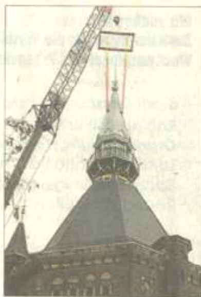
Der Neue Wasserturm nun wieder mit kompletter Spitze.
