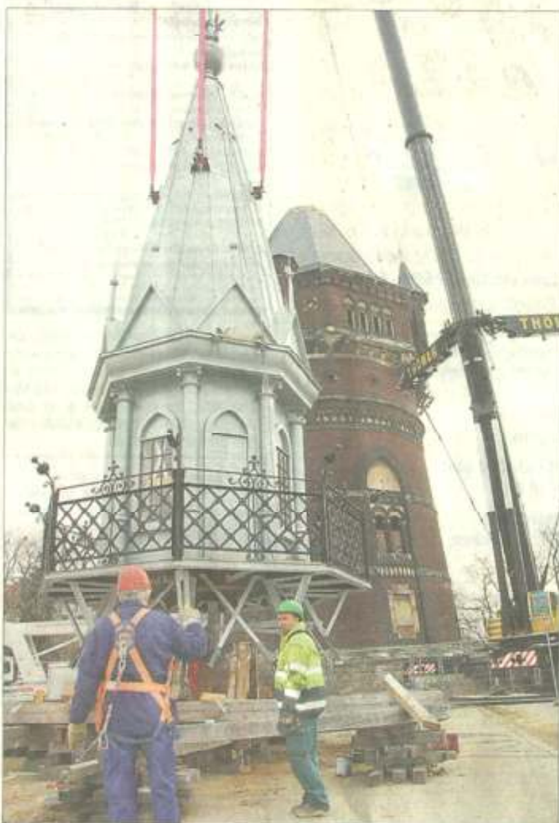
Gut gesichert verlässt die 14,5 Tonnen schwere Laterne ihren Bauplatz und schwebt am Kranseil hinauf zu ihrem alt angestammten Platz.
