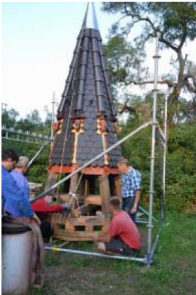
Der 2. Vorsitzende des Wasserturnvereins Wilhelm Kleinschmidt (re. stehend) spricht vor dem Aufziehen des zweiten Erkerturms die letzten Details ab.
