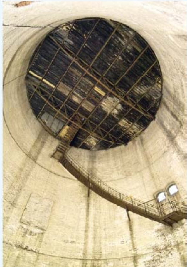
Blick in den Innenraum des Neuen Wasserturms.
